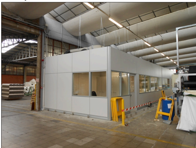
Foto1- lavori di realizzazione nuova struttura
