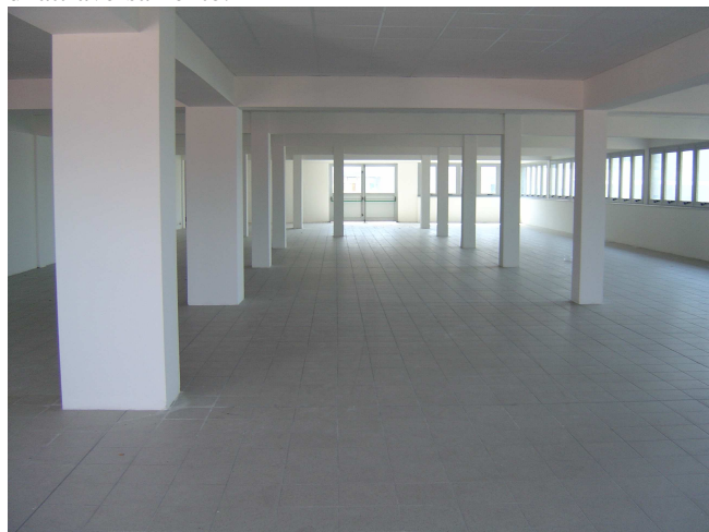
Foto 1 – Area laboratori prima della realizzazione
