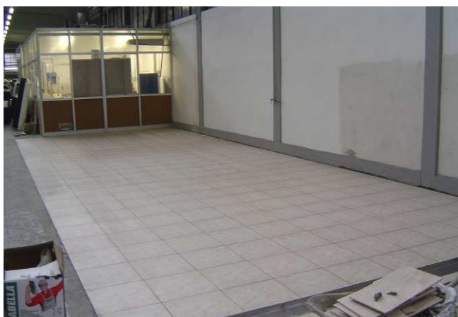
Foto 1 – Area laboratori ad inizio realizzazione con pavimentazione e scarichi
